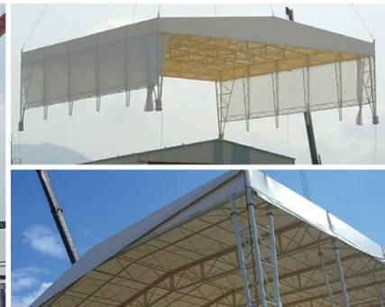
テント屋根自体が移動してその場から捌けてしまうと、従来の開閉式テントでは無理だったクレーンや重機、大型トラック等の搬入出が可能になり、大物の荷さばきや荷役作業が容易になります。必要な時にはスイッチひとつで屋根を戻すことが可能です。
